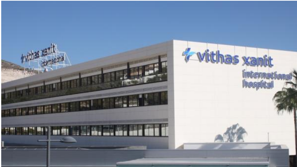
Fachada del hospital Vithas Xanit Internacional de Benalmádena (Málaga)
