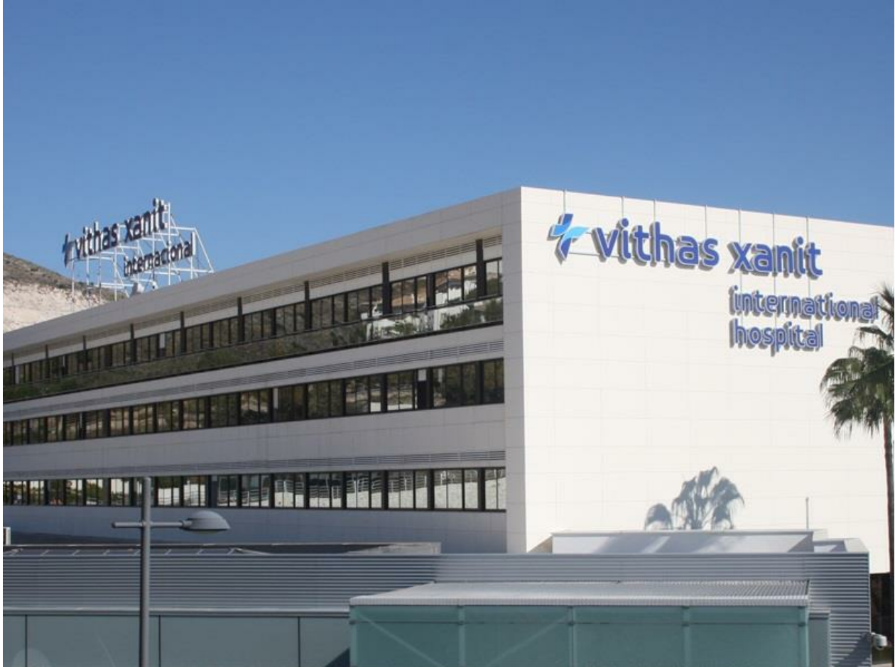
Fachada del hospital Vithas Xanit Internacional de Benalmádena (Málaga)
