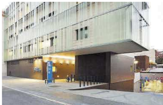
Fachada de la clínica Corachan en Barcelona.
